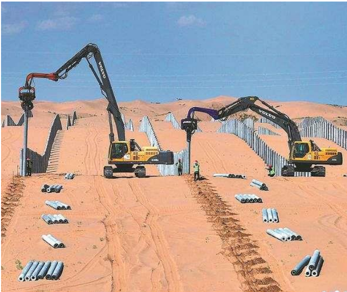
Il cantiere in corso d'opera
